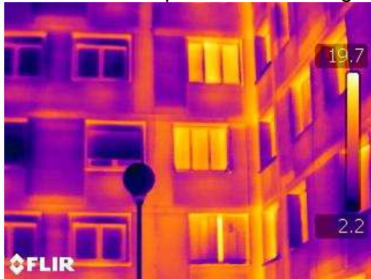
Menuiseries simple et double vitrage (en cours de travaux).
