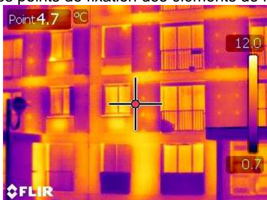
Façade "léopard" : ponts thermiques des points de fixation des éléments de façades.
